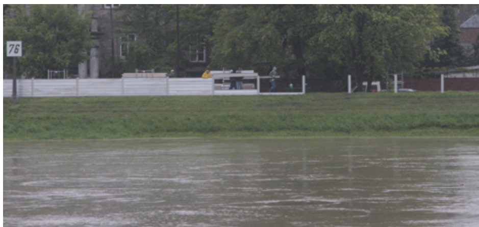
Przenośne ścianki przeciwpowodziowe montowane na wałach w Krakowie (fot. W. Skrzypiec)
