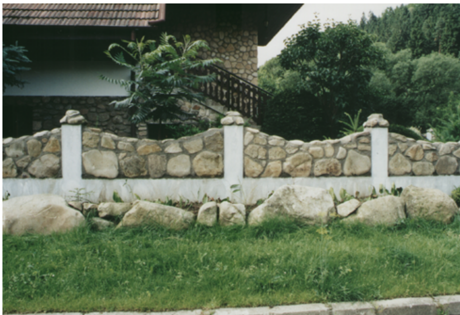
Mur zabezpieczający dom przed powodzią w Kotlinie Kłodzkiej (fot. R. Konieczny)
