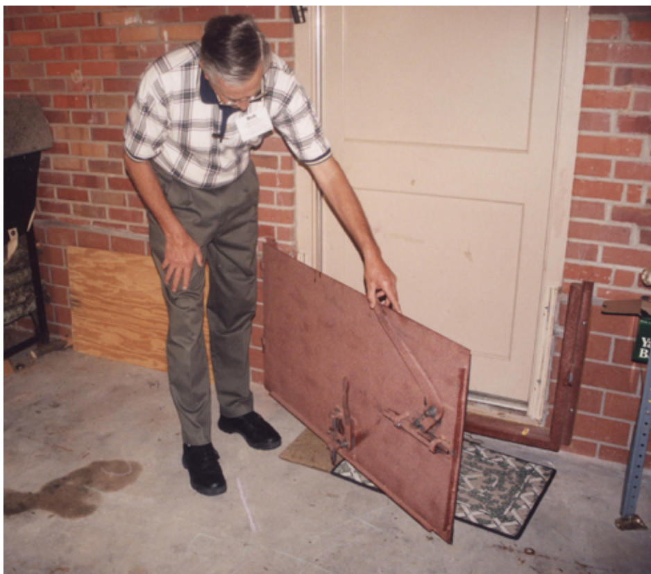
Uszczelniona ściana domu i zabezpieczenie na drzwi (fot. R. Konieczny)
