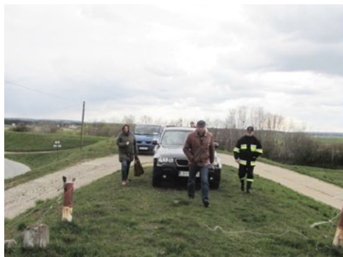
Kontrola wału przeciwpowodziowego (fot. FWW)
