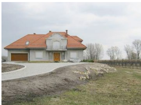
Przykład domu zbudowanego na nasypie (fot. Małgorzata Siudak)
