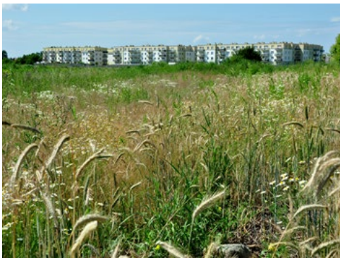
Chaotyczna zabudowa powstająca bez planu miejscowego wygląda jak wyspa otoczona terenami rolnymi (fot. Jolanta Pawlak)
