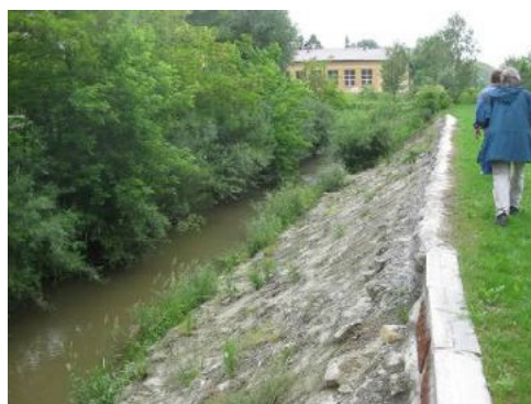
Umocnienie skarpy koryta i wału na potoku (fot. Małgorzata Siudak)
