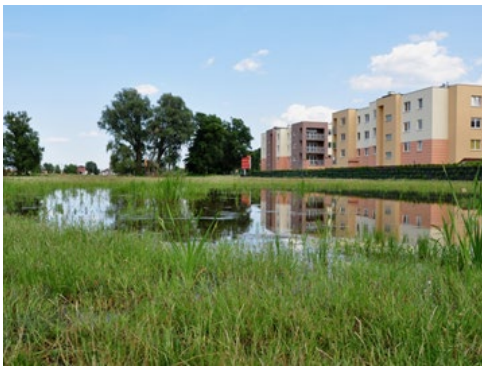
Wprowadzenie zabudowy mieszkaniowej na podmokłych łąkach zniszczyło układ melioracyjny i spowodowało zalanie terenów sąsiednich (fot. Jolanta Pawlak)
