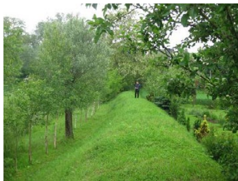
Przykład gospodarstwa otoczonego wałem przeciwpowodziowym (fot. Roman Konieczny)
